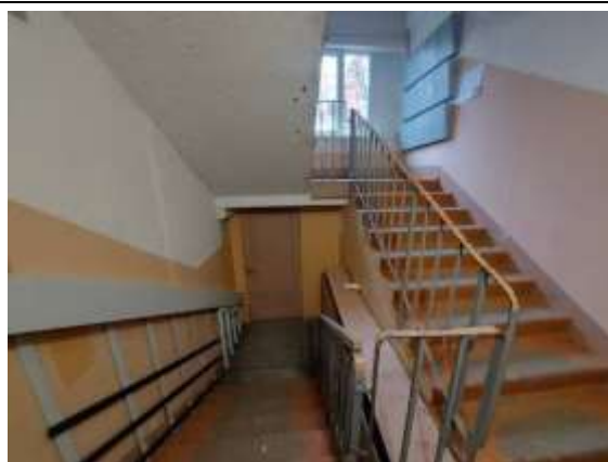
1.stāva kāpņu telpa
